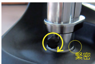
5. 向下旋轉安裝到無縫隙，再順時針鎖緊黑色螺絲
